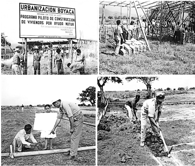
Figs.104-8 Construction process of Urbanización Boyacá, Colombia. Source: CINVA, 'Urbanización Boyacá'.
